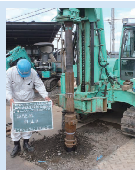
打設完了(打ち止め)
