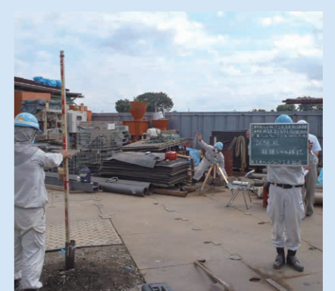
打設完了(レベル確認)
