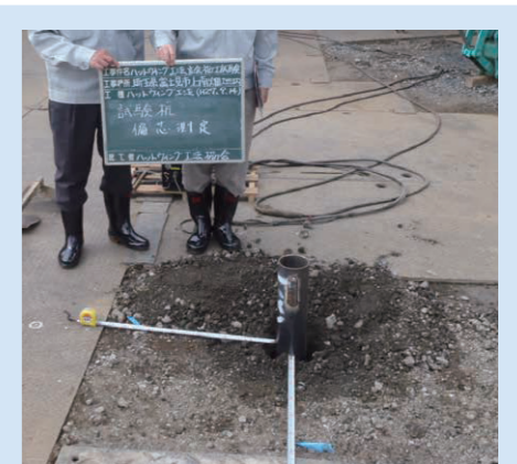
打設完了(偏芯確認)
